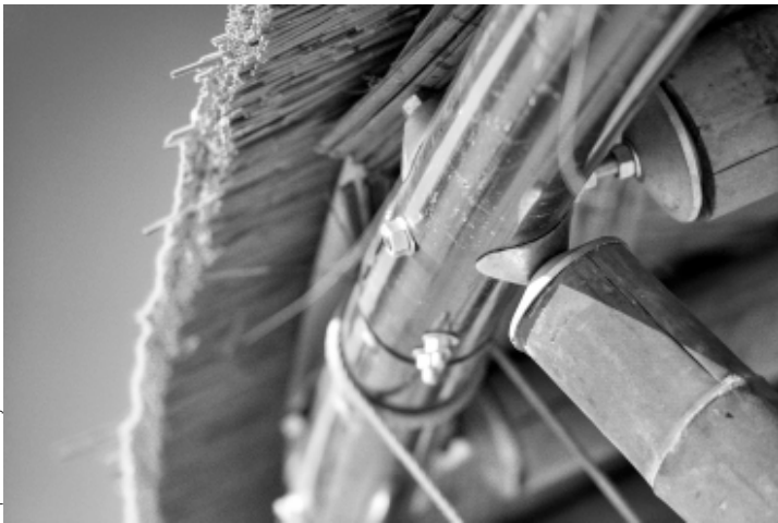
Ci-dessus : la couverture en roseaux de Camargue a été fournie et posée par une entreprise locale.
