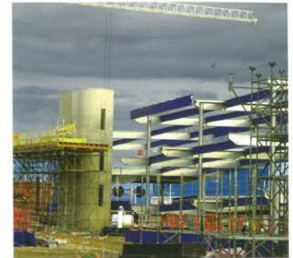
Photo 2 : Vue du contreventement par les noyaux / Bracing nodes viewing
